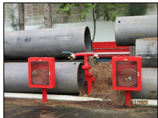
รูปที่ 73 ระบบดับเพลิงแบบ Fire Hose ภายในพื้นที่โครงการ
