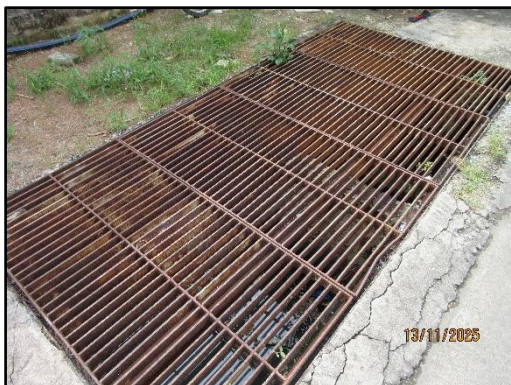
รูปที่ 20 ป่อพักน้ำก่อนปล่อยออกจากพื้นที่โครงการ
