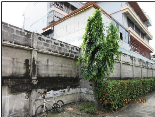
รูปที่ 2 กำแพงถาวรสูง 3 เมตร ที่มีวัสดุอุดซับเสียง ด้านติดกับโรงเรียนศิริวิทยา
