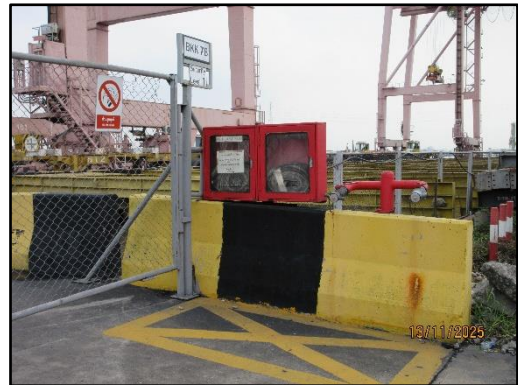
รูปที่ 73 (ต่อ) ระบบดับเพลิงแบบ Fire Hose ภายในพื้นที่โครงการ
