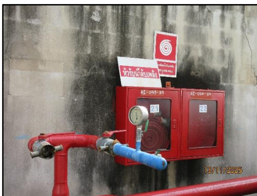
รูปที่ 73 ระบบดับเพลิงแบบ Fire Hose ภายในพื้นที่โครงการ
