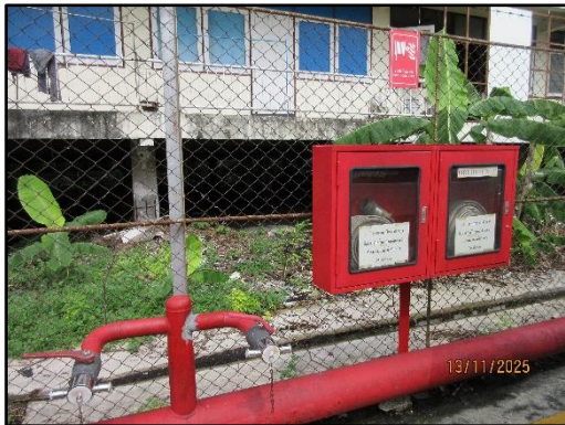
รูปที่ 73 (ต่อ) ระบบดับเพลิงแบบ Fire Hose ภายในพื้นที่โครงการ
