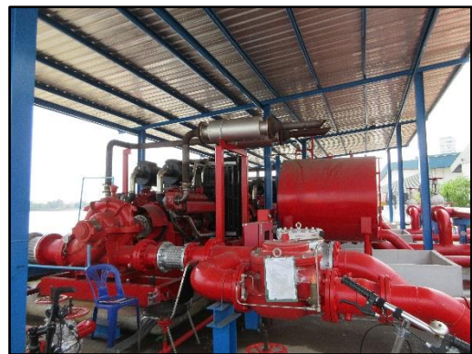
รูปที่ 74 เครื่องสูบน้ำ บริเวณท่าเทียบเรือ
