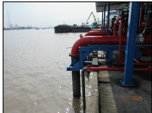
รูปที่ 33 บริเวณจุดสูบน้ำจากแม่น้ำเข้ามาใช้ในโครงการ
