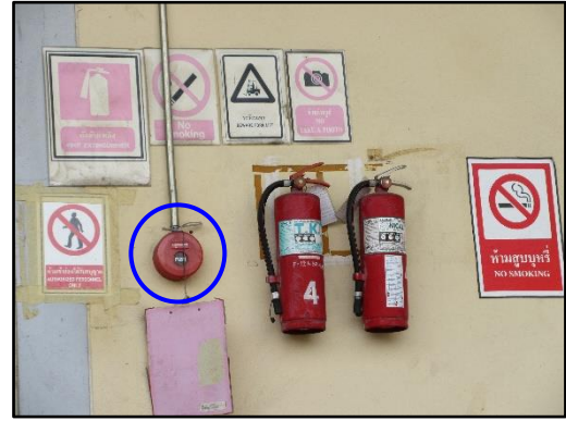
รูปที่ 63 อุปกรณ์แจ้งเหตุด้วยมือ
