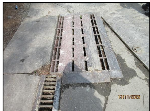
รูปที่ 21 ท่อระบายน้ำฝนโดยรอบพื้นที่โครงการ
